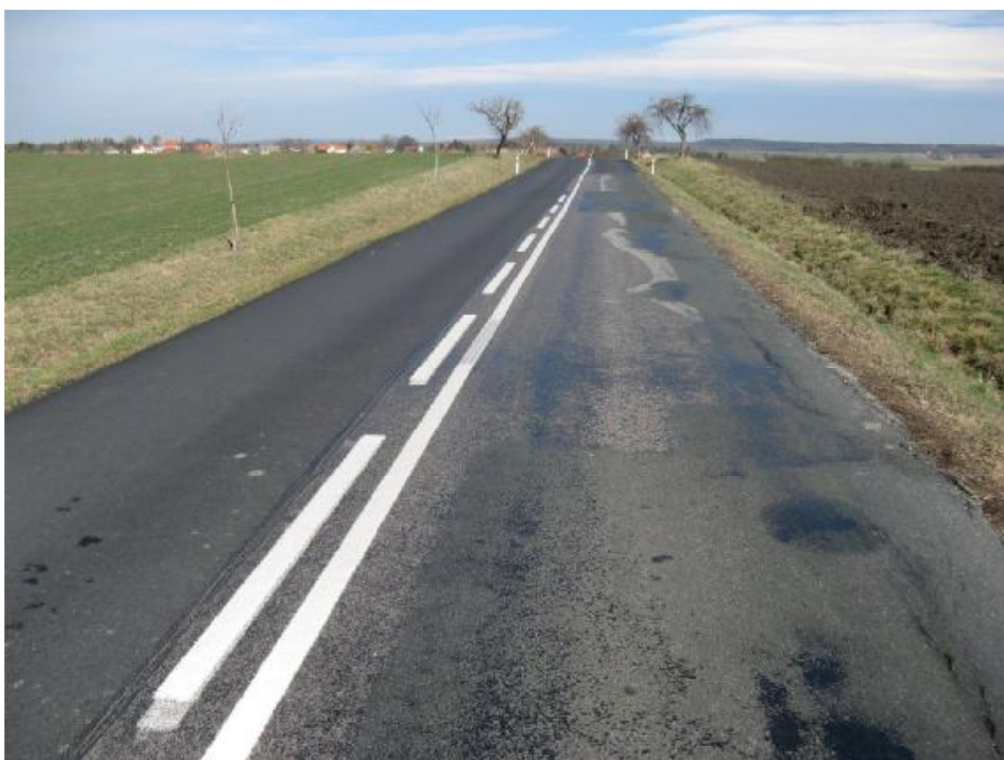
F53, km 23,610+ Vlevo oprava povrchu, vpravo ztráta makrotextury a olamování okraje vozovky.
