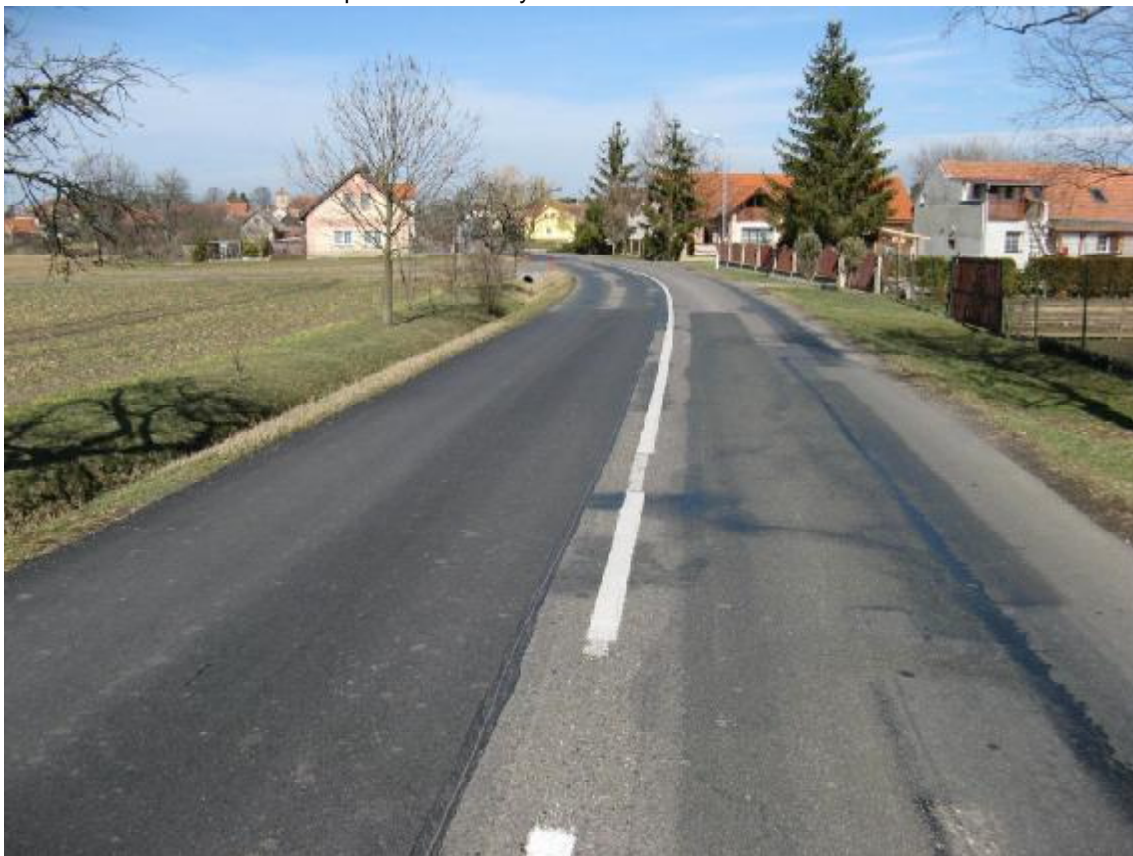
F65, km 24,210+ Vlevo oprava povrchu, vpravo vysprávka okraje vozovky.
