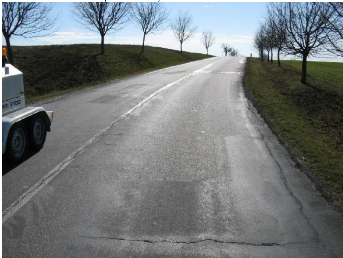
F100, km 26,100- Olamování okraje vozovky, příčné trhliny.
