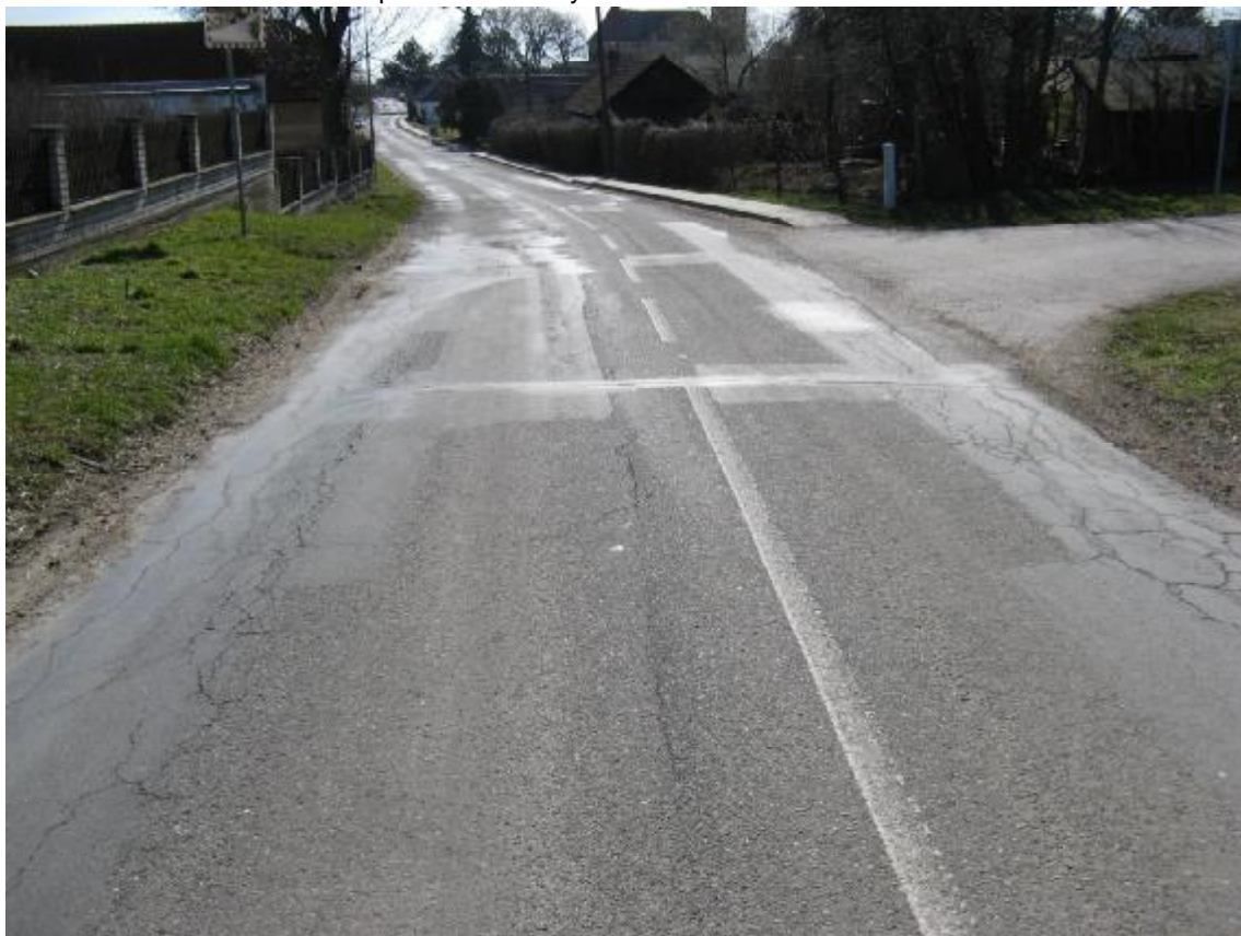
F80, km 25,100- Příčné trhliny, síťové trhliny podél okraje vozovky.
