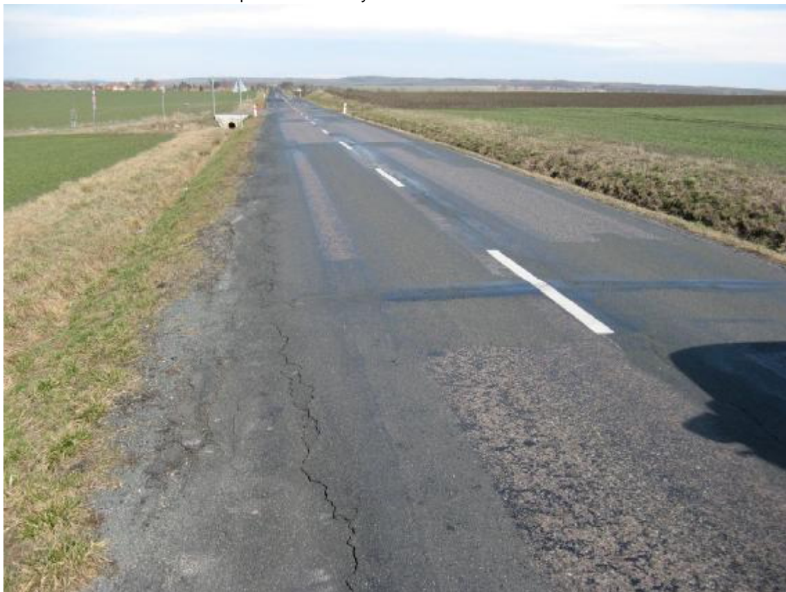
F47, km 23,310+ Příčné trhliny a olamování okraje vozovky.
