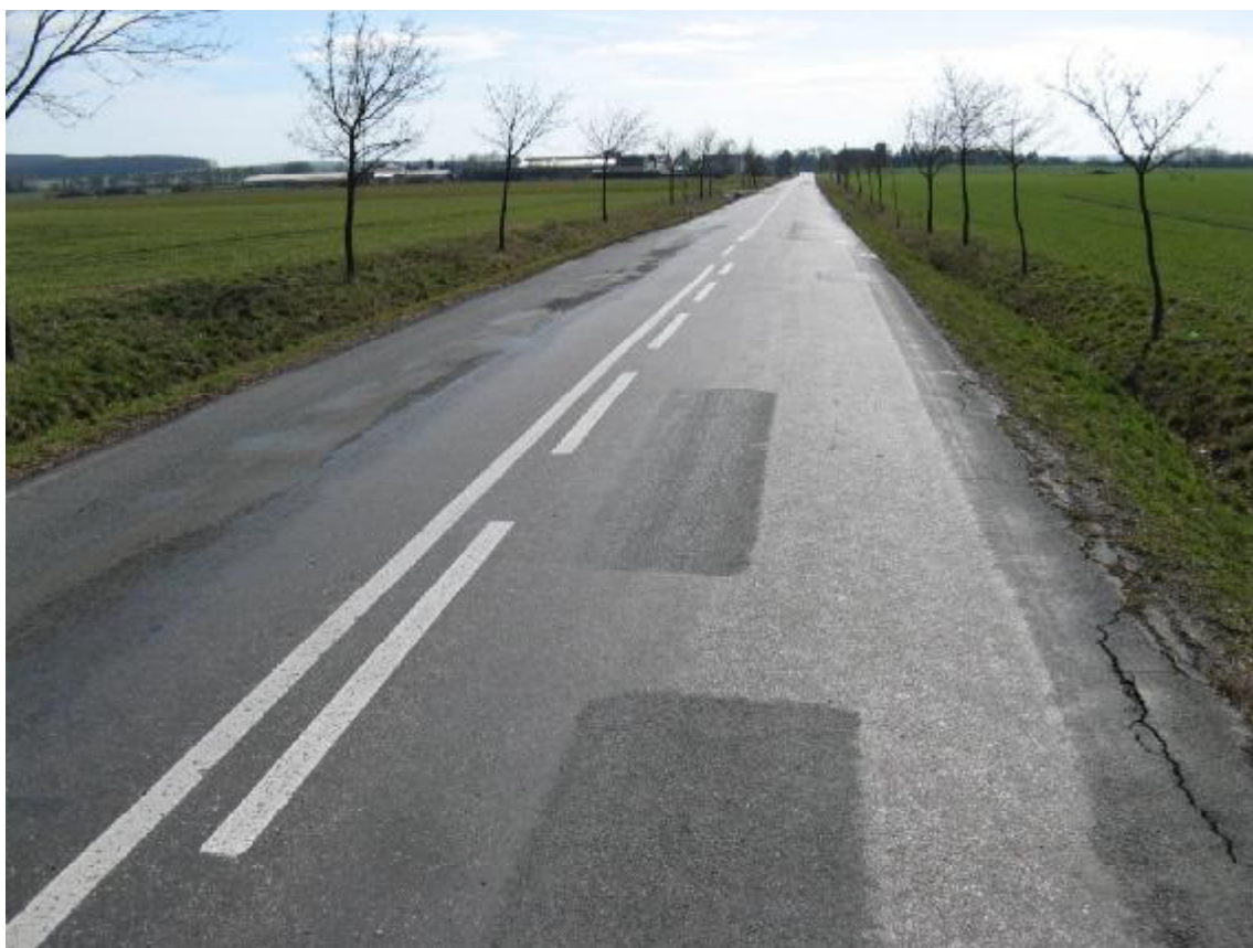
F80, km 25,800- Olamování okraje vozovky, ztráta makrotextury.
