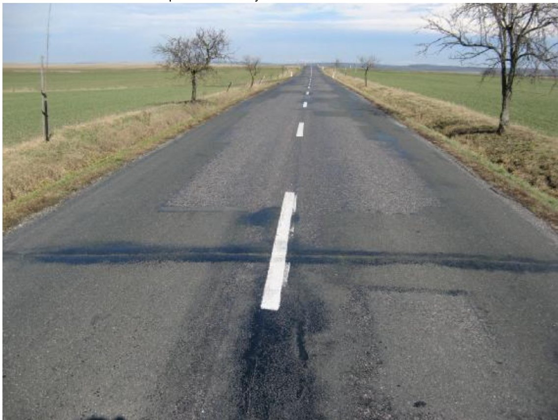
F24, km 22,210+ Příčné trhliny.
